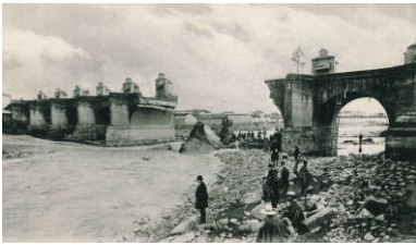
Demolición Puente Cal y canto 1888
