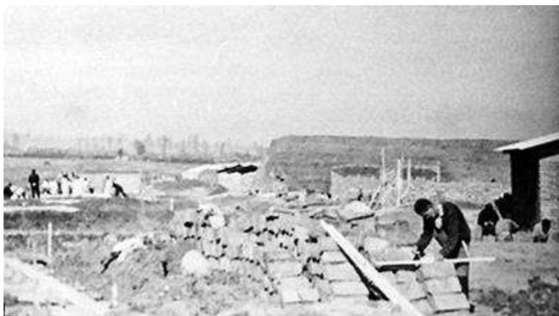
Fig. 19. Fabricación de los ladrillos con tierra del lugar, c. 1967.
