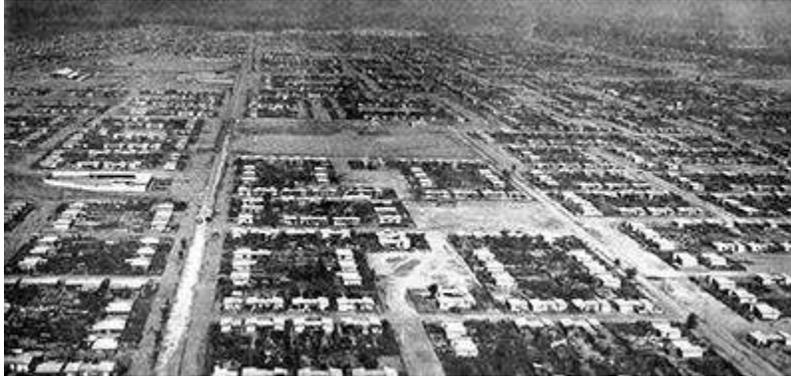
Fig. 6. Operación San Gregorio, c. 1959. Cerca de 25.000 ex-habitantes de poblaciones callampas de Santiago cooperaron en la construcción de sus viviendas. Se utilizaron sistemas constructivos a base de paneles prefabricados en madera para acelerar el montaje. Fuente: CORVI, 1963, p. 99
